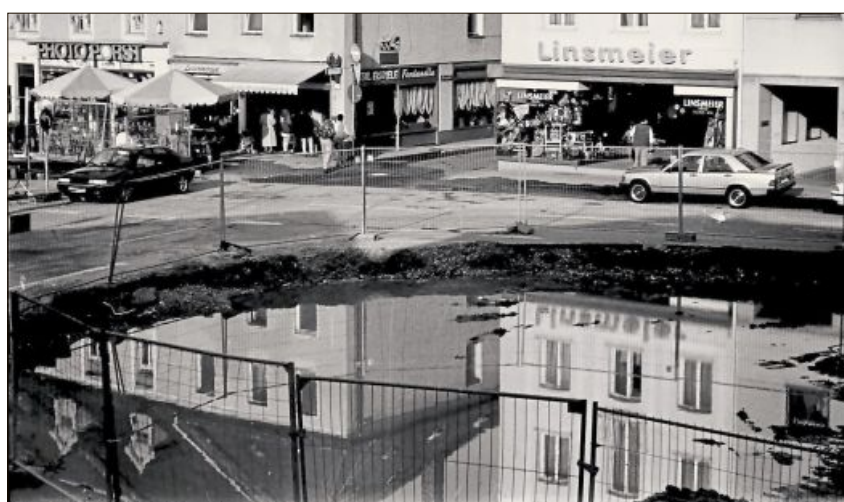
Nur drei Tage vor dem „Spatenstich“ am 6. September hatte sich die Baugrube für die Tiefgarage nach tagelangen Regenfällen in einen See verwandelt.
