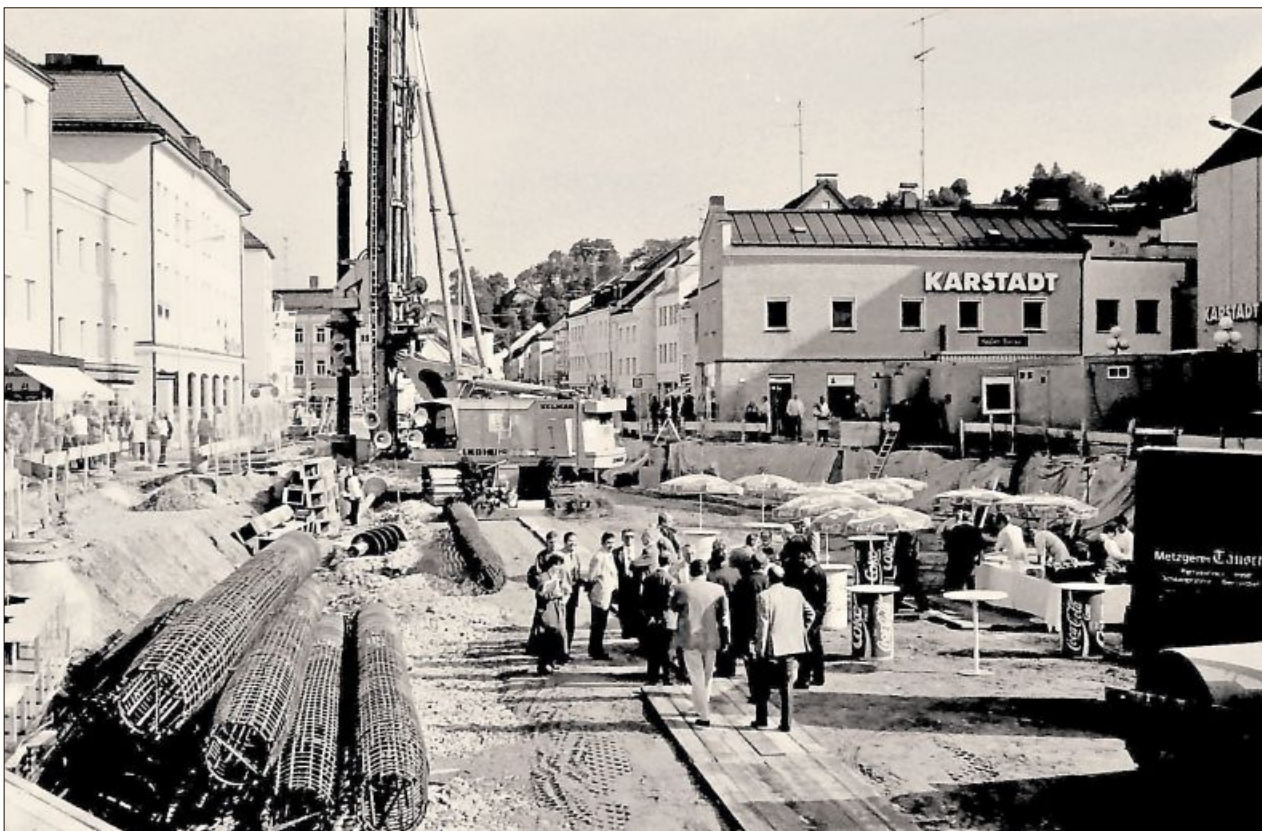
Die Baugrube zur Tiefgarage am Oberen Stadtplatz am Tag des ersten offiziellen Spatenstichs, am 6. September 1995.
